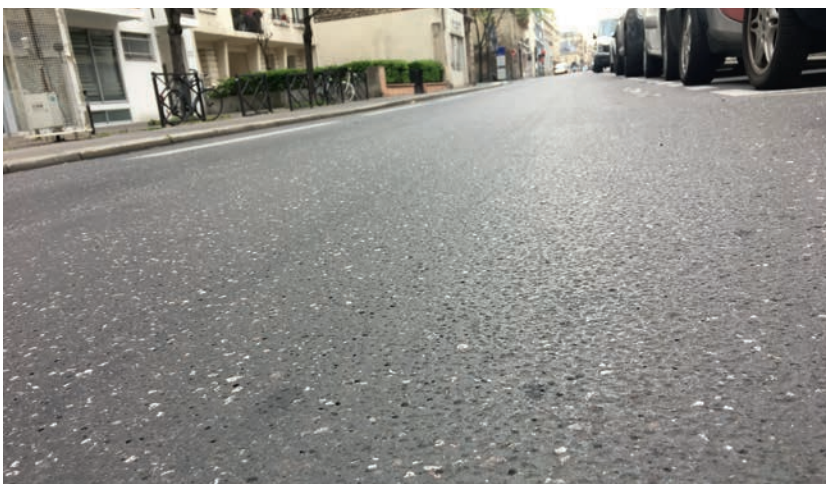
–Photo 1– Asphalte coulé innovant Puma rue Lecourbe.
