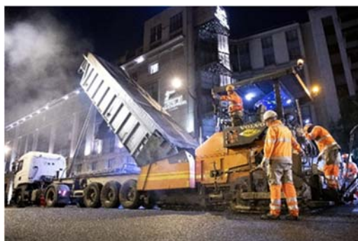
Photo 6 - Mise en œuvre du BBphon+ rue de Courcelles de nuit
