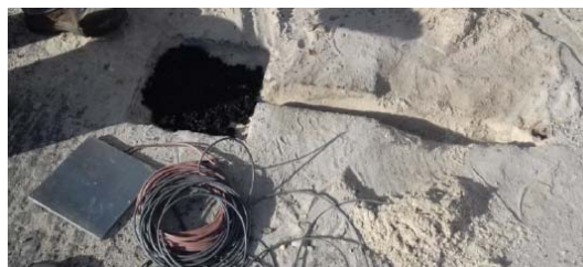
Photo 4 - Pose d'un capteur de flux thermique
