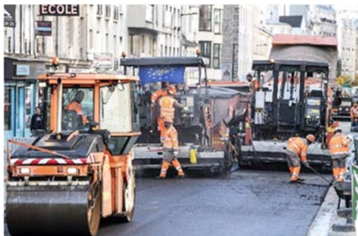
Photo 5 - Mise en œuvre du SMAphon rue Frémicourt)
