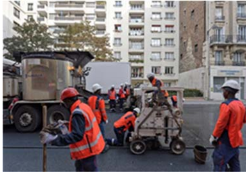
Photo 8 - Alimentation du finisseur à asphalte avec le PUMA
